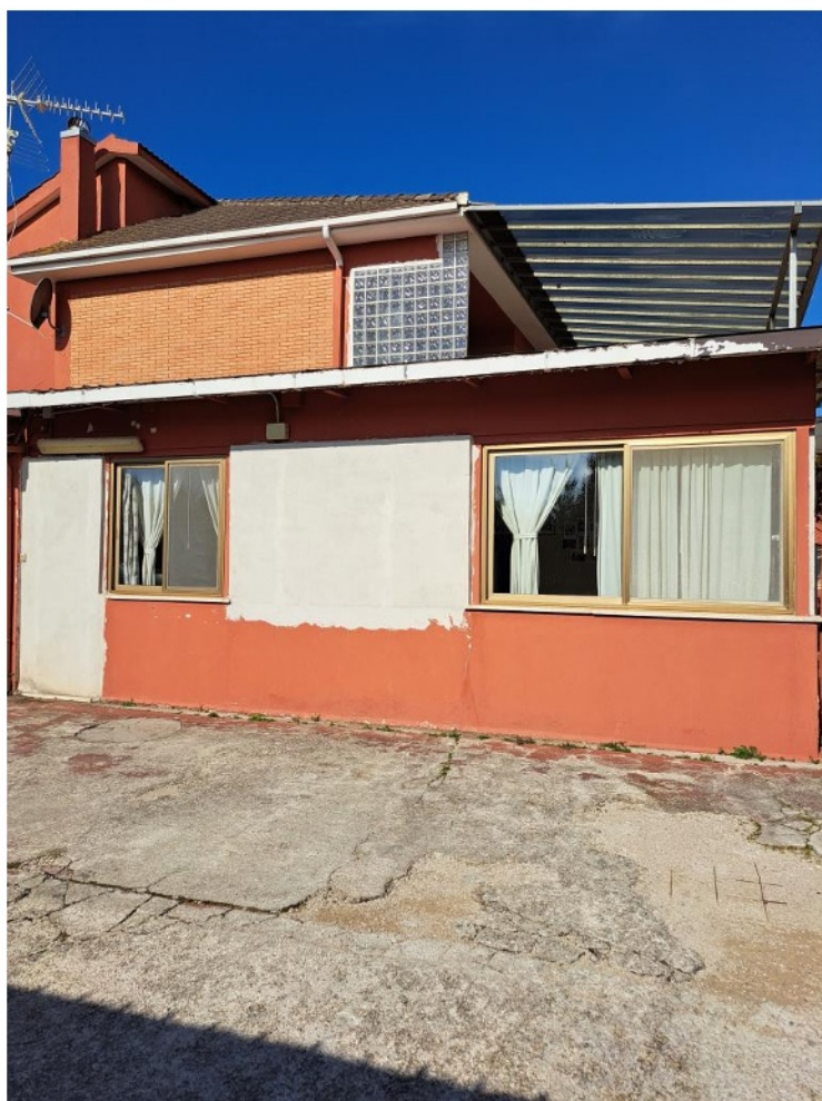
Foto n° 9 – facciata laterale del mini appartamento (ampliamento da condonare)
