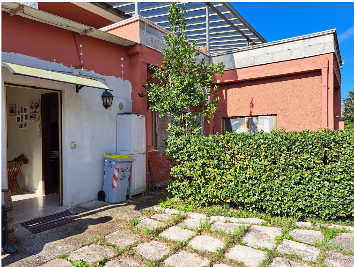
Foto n° 8 – secondo ingresso per la zona utilizzata a mini appartamento
